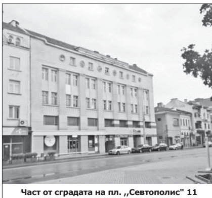
Част от сградата на пл. „Севтополис“ 11
